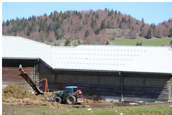
Le bâtiment agricole, en forme de L, abrite une étable pour 28 vaches laitières et permet le stockage du fourrage
