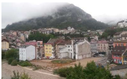
Ci-dessus : photos avant et après travaux Crédits © PNRHJ / M.Peroz
