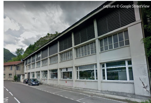
Le bâtiment communautaire à réhabiliter
