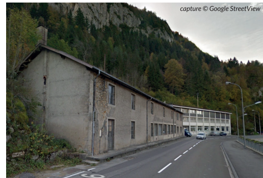
Le bâtiment communal prochainement démolir
