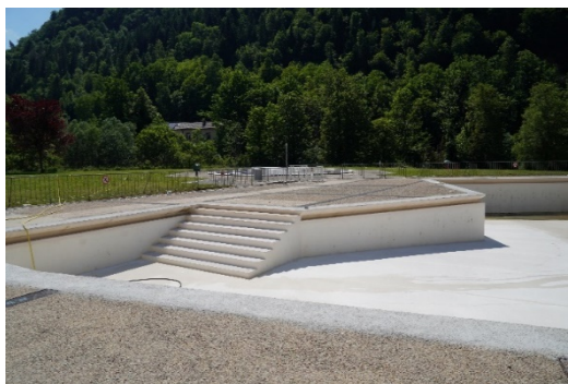
Vidange et nettoyage des bassins du Centre Nautique du Martinet / © Communauté de communes Haut-Jura Saint-Claude
